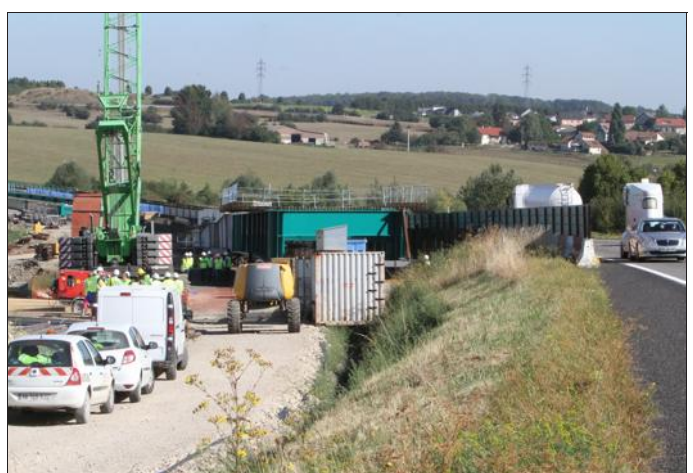
Depuis cet hiver, les travaux de doublement de six des 12 km accidentogènes ont été lancés avec la construction d'un pont entre Hertzling et Hémigny. Photo Laurent MAMH
