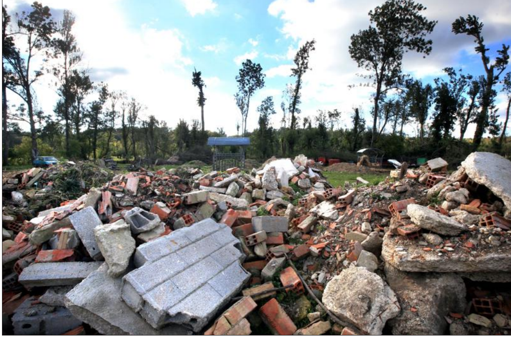
La commune de Robert-Espagne, un an après le passage de la tempête Henri qui a mis en ruine l'ancien bâtiment agricole de l'EARL de Lerins, reconstruit depuis. Photos Pascal BROCARD
