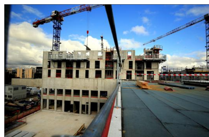
Les élus messins ont posé, hier, la première pierre du premier immeuble en construction sur le socle commercial Muse ; il s'agit de logements sociaux pour Metz Habitat Territoire. Photo Karim SIARI
