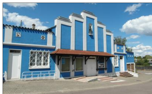
La façade du cinéma au Val-de-Guéblange. Photo DR
