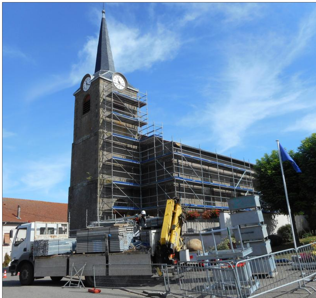
L'église s'est couverte d'un échafaudage pour faire peau neuve, l'appel au mécénat est renouvelé pour financer les travaux. Photo RL
