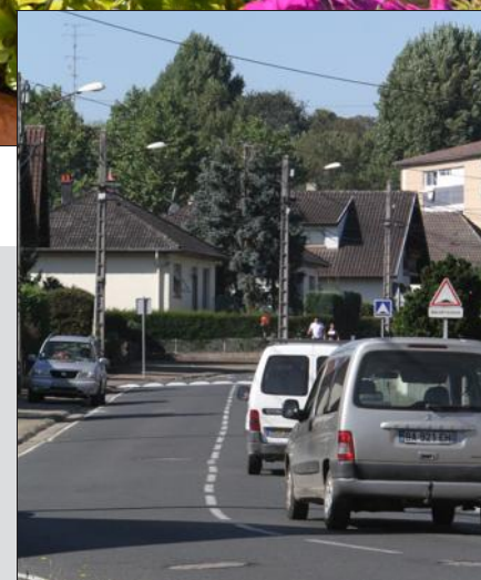
Un rétrécisseur de chaussée sera aménagé rue des Chardonnerets.
