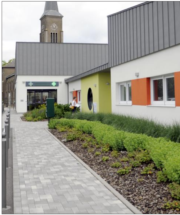
La maison de santé grostenquinoise est la seconde construite en Moselle et la première mise en fonction.
