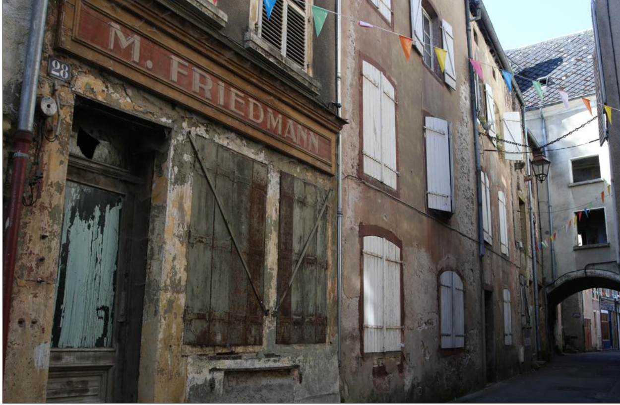
Au moins 17 bâtiments aux façades décrépies menacent ruine au centre du bourg. Ils sont désormais dans le collimateur du maire qui veut redonner du cachet à sa commune et la rendre attractive. Photo Pierre HECKLER
