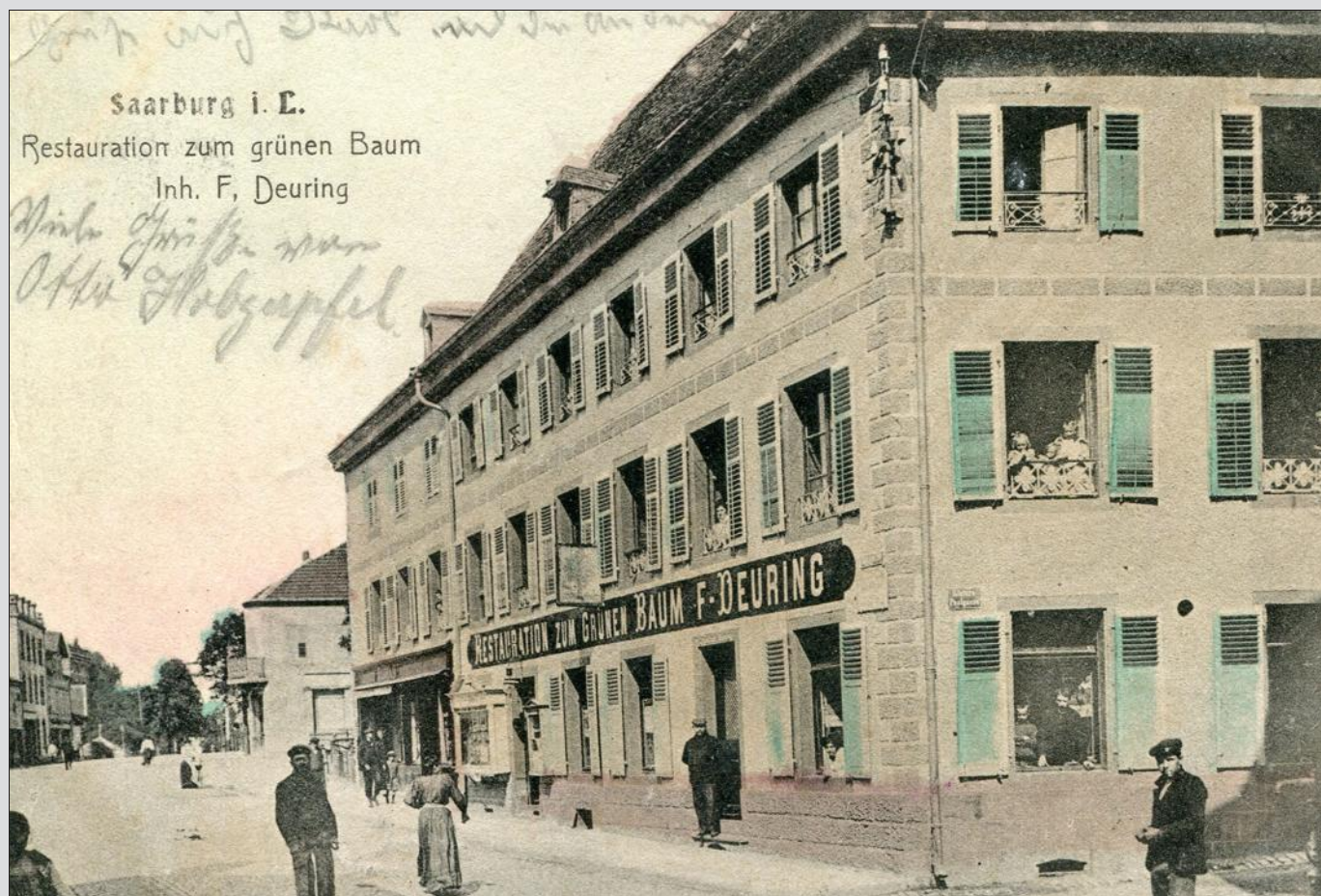
Le haut de la rue du Maréchal Foch en 1908, avec le restaurant Zum Grünen Baum. Collection des Amis du Vieux Sarrebourg
