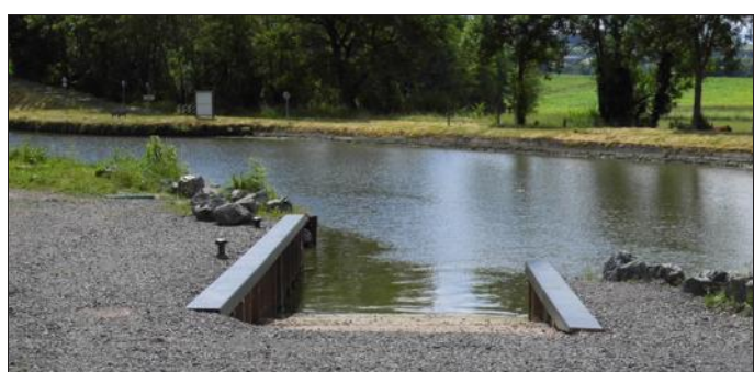
La rampe vue de la piste cyclable 2. Photo RL
