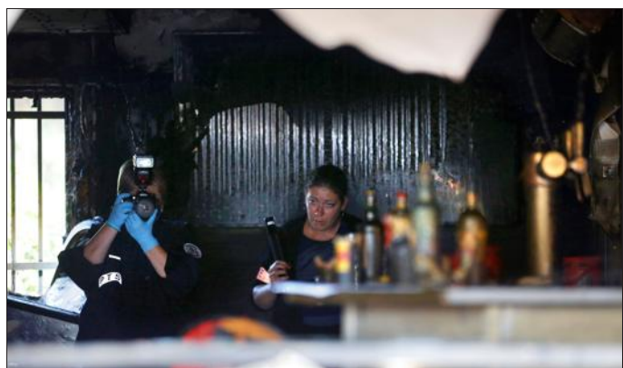
Les enquêteurs s'interrogent sur l'isolant phonique qui recouvrait le plafond du sous-sol où se sont retrouvées coincées les victimes.
