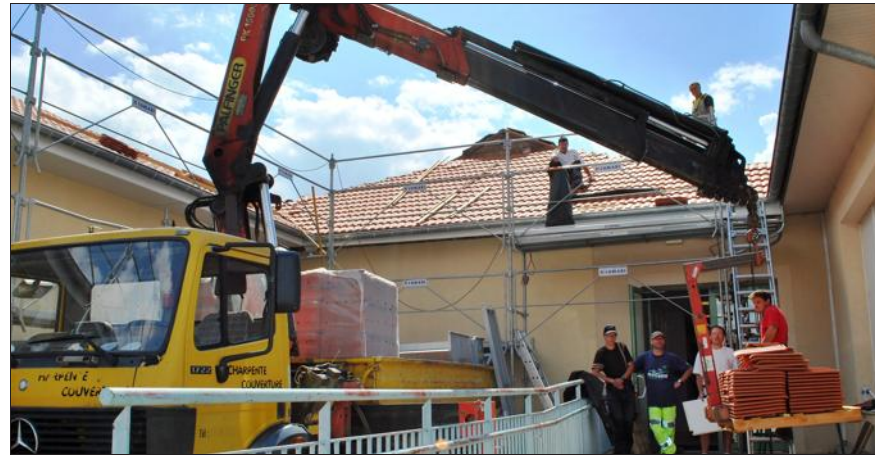
La surface de la toiture à rénover est de 852 m 2 . Les travaux sont réalisés dans les temps : l'école sera prête pour la rentrée des classes.
