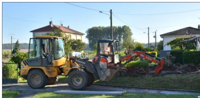
Les opérations de déconnexion des fosses septiques et bacs dégraisseurs se sont faites avec la participation des propriétaires. Photo RL.
